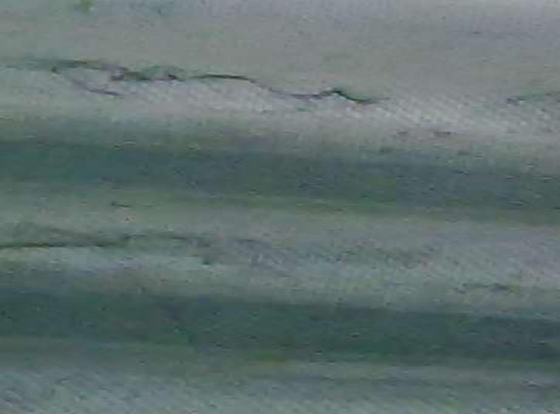
Dopo anni di installazione, tuttavia, le coperture esposte ad agenti atmosferici, subiscono un *deterioramento*, per azione delle piogge acide, degli sbalzi termici, dell'erosione eolica e di microrganismi vegetali, che determina alterazioni corrosive superficiali con affioramento delle fibre e fenomeni di liberazione.
